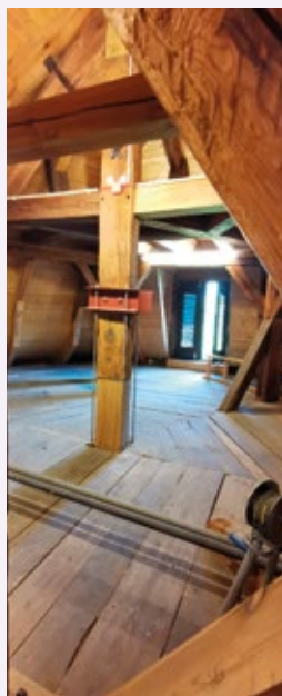
Bodenraum unterhalb der Glockenstube
