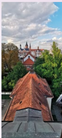
Ausblick nach Nordosten
